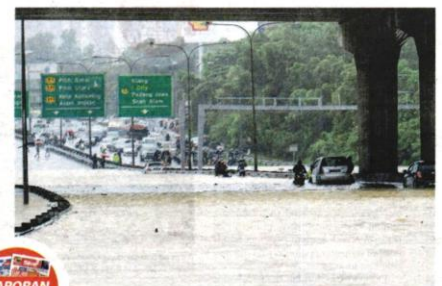
Kedudukan banjir kilat akibat limpahan air dari Sungai Demansara mengakibatkan Jalan di Batu 3, Lebuhraya Persekutuan ditanggulami air dan tidak boleh dilalui oleh kenderaan kerana tiupan pada Sabtu.
